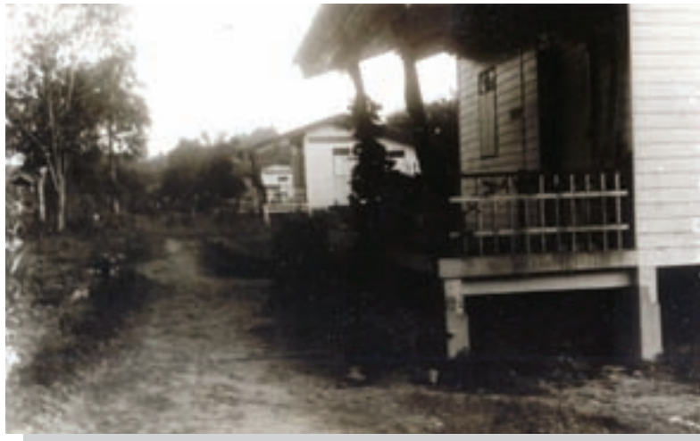
บ้านพักอาจารย์
